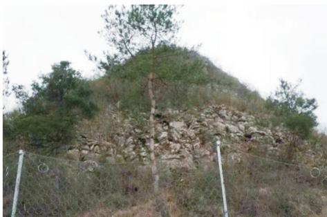
图 3 尖坡主动防护网现场设置
