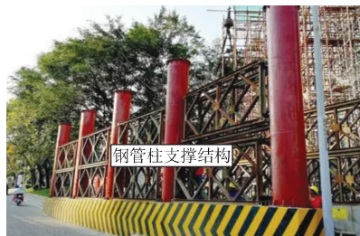
图 3 钢管柱支撑安装施工示意图
