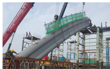
a) 钢管拱肋吊装施工图
