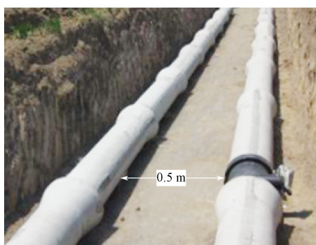
图6 管道排布施工间距
