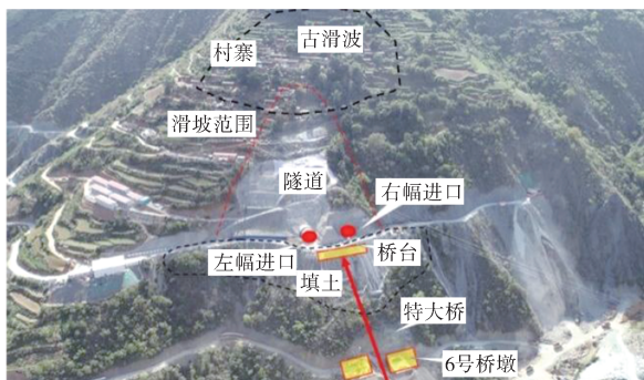
图 1 某高速公路隧道滑坡全貌
