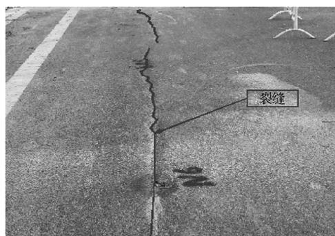
图2 外贸路路面裂缝照片
