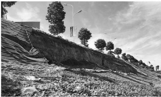
图4 边坡坡体下挫图片
