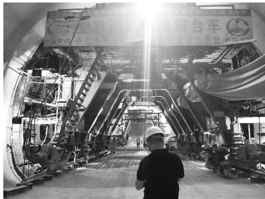
图 1 隧道模板台车实景图
