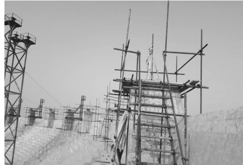
图11 劲性柱上测站布置
