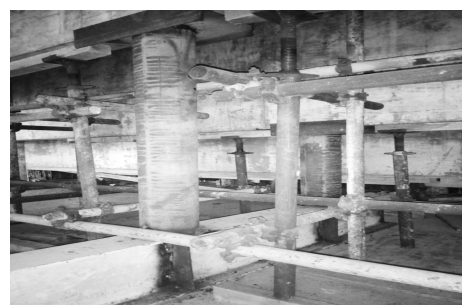
图7 层间支撑体系示意图
