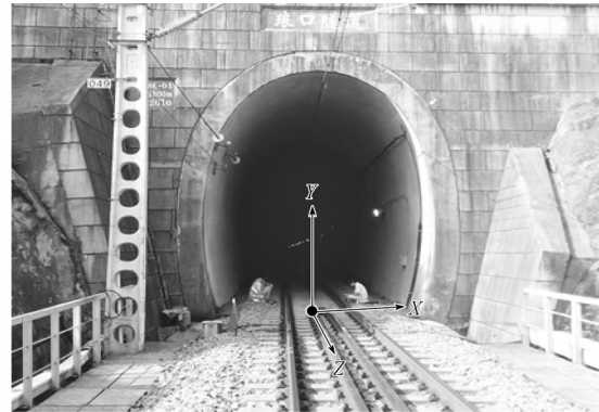
图 3 轨枕测点布置图
