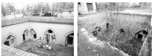
图2 地上房屋和地坑院共存
