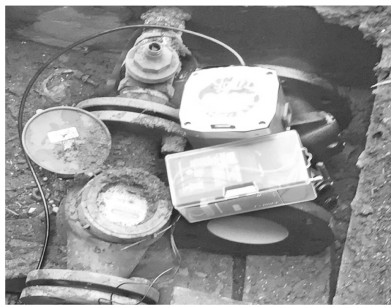
图 10 LoRa 模块现场安装图
