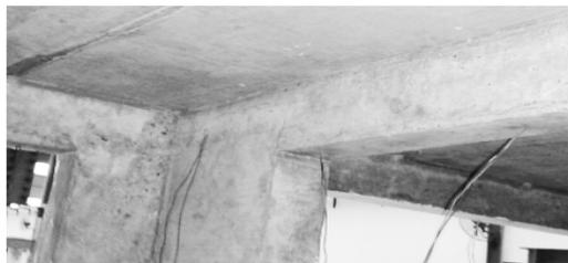
a) ②号轴线二层梁端裂缝
