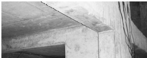
d) ②号轴线三层梁端裂缝
