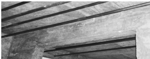
e) ②号轴线顶层梁端剪切裂缝
