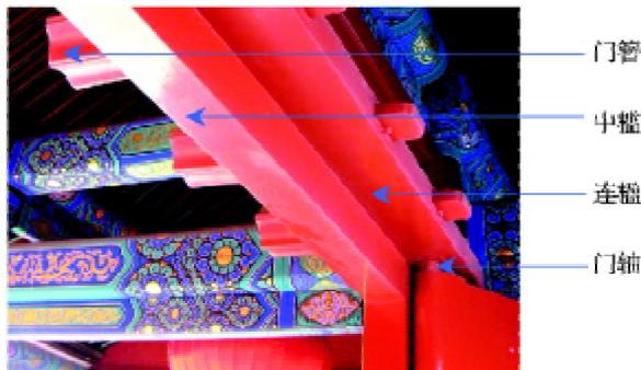
图2 门簪、中槛、连楹和门轴的关系示意图
